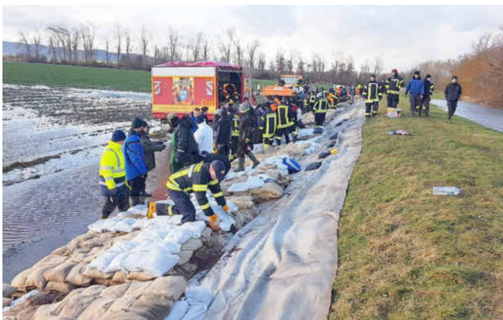
Einsatzkräfte aus Anhalt-Bitterfeld helfen bei der Deichverteidigung in Martinsrieth.
