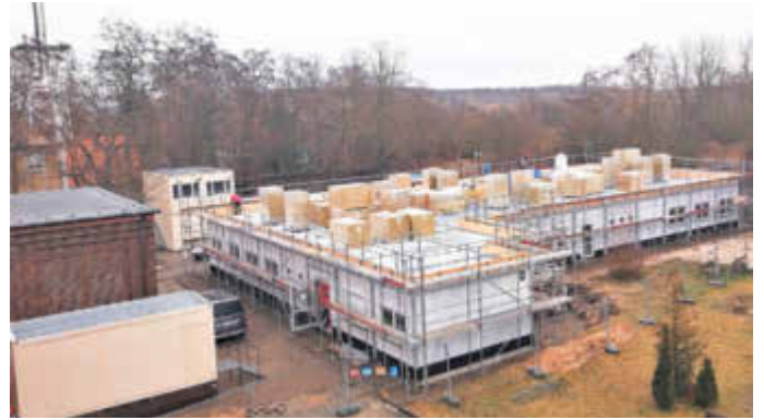
Die Bauarbeiten am Neubau für die Förderschule „An der Kastanie“ in Bitterfeld gehen zügig voran.
