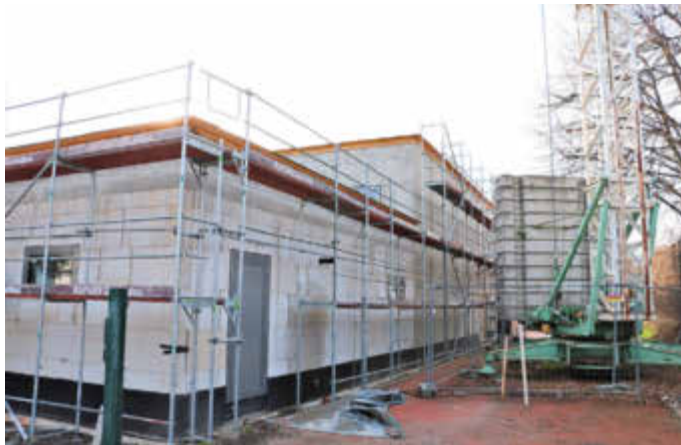
Der Neubau der Turnhalle der Köthener Sekundarschule „Völkerfreundschaft“ schreitet voran. Die Investitionsmaßnahme des Landkreises soll 2024 abgeschlossen werden.
