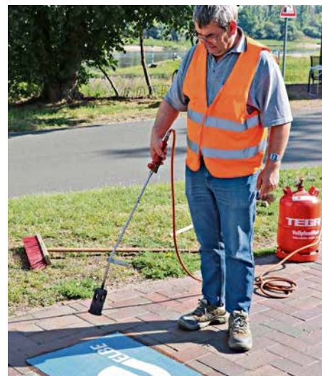
Die Fertigmarkierung wird auf der Fahrbahn aufgeschweißt.
