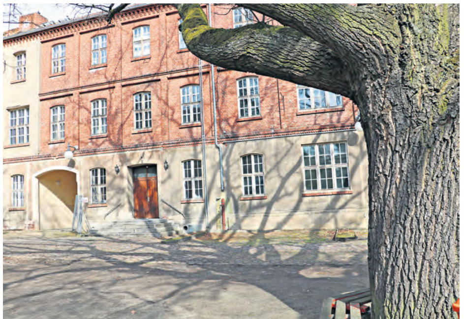
Der sogenannte Kasernenflügel im Gebäudekomplex des ehemaligen Frauenklosters.
