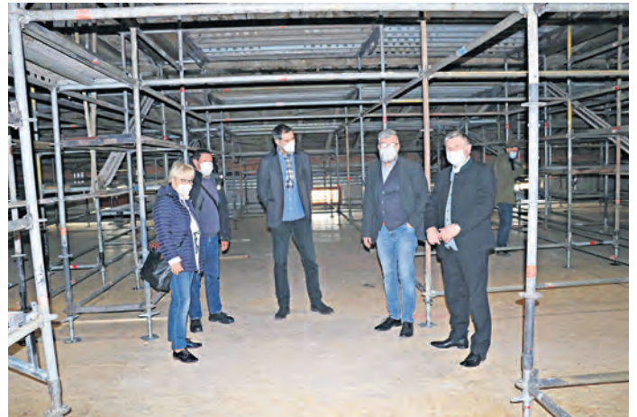
Ein Teil des Dachgeschosses wird als Ausstellungsfläche aus- gebaut.
