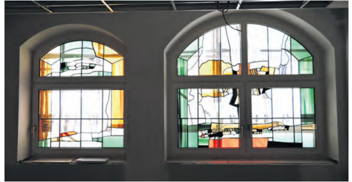
Die Glasfenster in der Galerie gestaltete Christiane Schwarze-Kalkhoff. Eine Glaserei arbeitete dieses Buntglasfenster in eine Drei-Scheiben-Isolierverglasung ein. Somit sind sie vor Wärme, Sonnenlicht und Einbruch geschützt.
