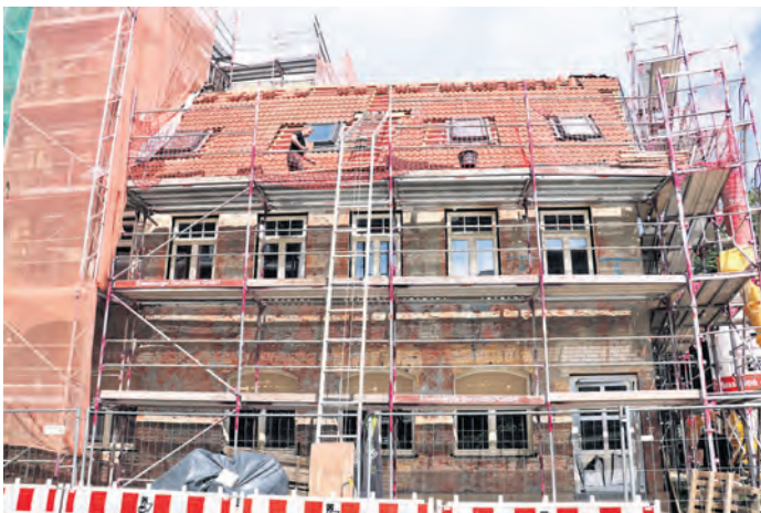
Auch am Gebäude in der Grünstraße laufen die Arbeiten.
