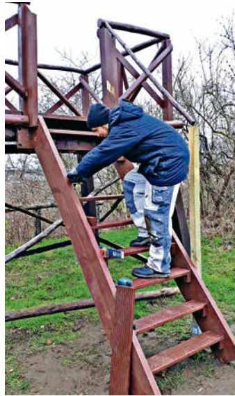
Olaf Winkler hält die Außenanlagen instand.
