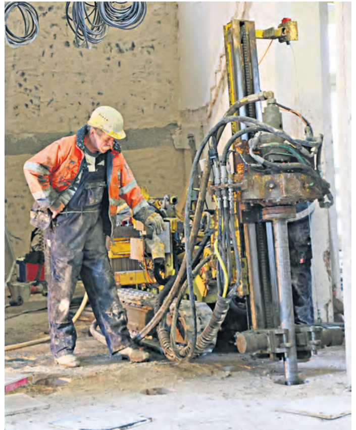
Im Erdgeschoss laufen die Kernbohrungen.
