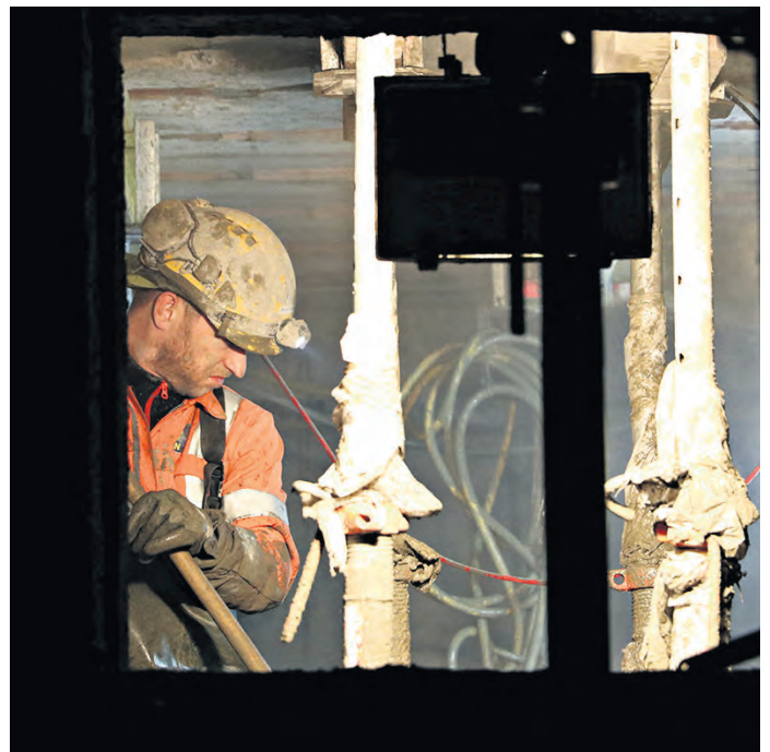
Im Keller erfolgt auf engstem Raum der Materialaustausch. Das alte Gemisch wird nach draußen geschaufelt.
