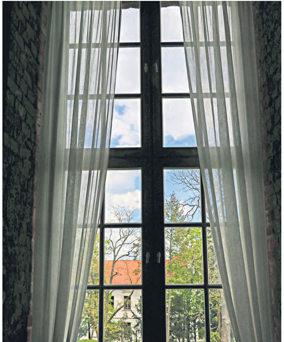
Eines der 64 neuen Fenster.
