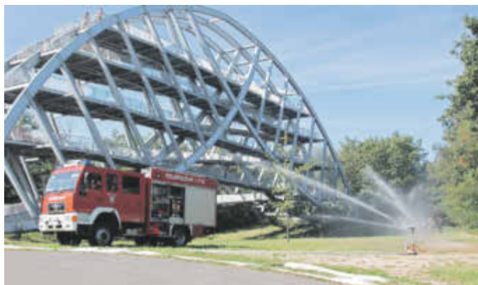
Die Wasserversorgung ist am Einsatzort gesichert. Wasser marsch für die Kreisregner der Wassergasse.
