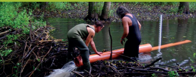
Abbildung 6 Befestigen des Rohres im Damm und im Wasser (Winkelprofil im Hintergrund!)
