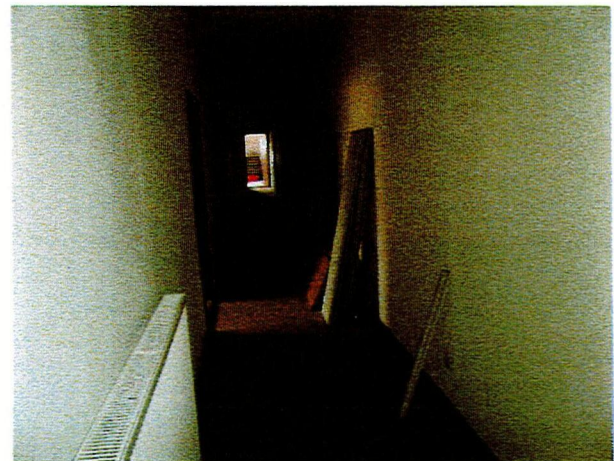
Hauptgebäude DG – Flur
