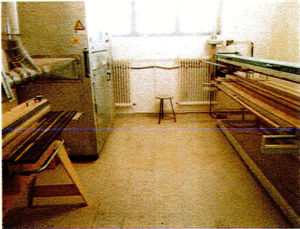
Nebengebäude EG – Werkstatt
