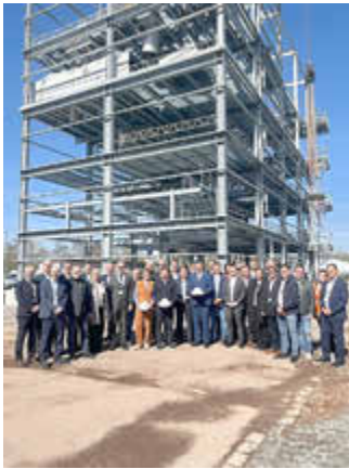
Erfolgreiches Richtfest für neuen Sprühturm der IBU-tec in Bitterfeld-Wolfen
