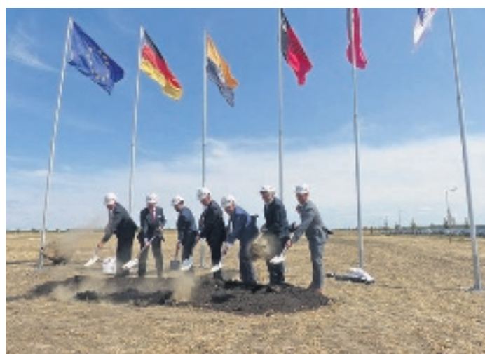
Vereint für die Zukunft, Spatenstich für die neue Papierfabrik in Sandersdorf.
