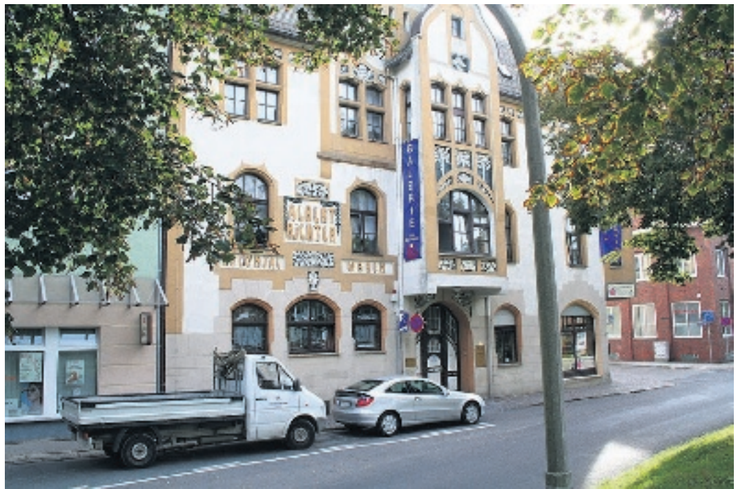
Das Gebäudeensemble Musikschule/Galerie in Bitterfeld wird energetisch saniert.
